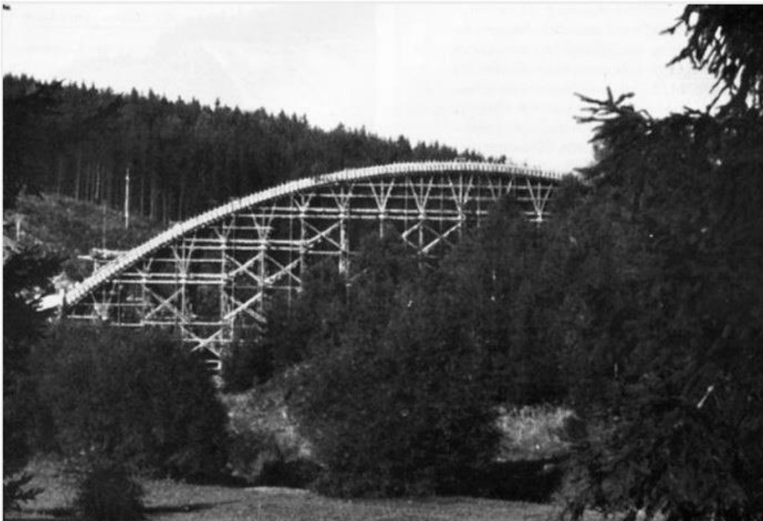
Obr. 7 Stavba skruže oblouku pod pravou částí mostu ve směru do Brna.
