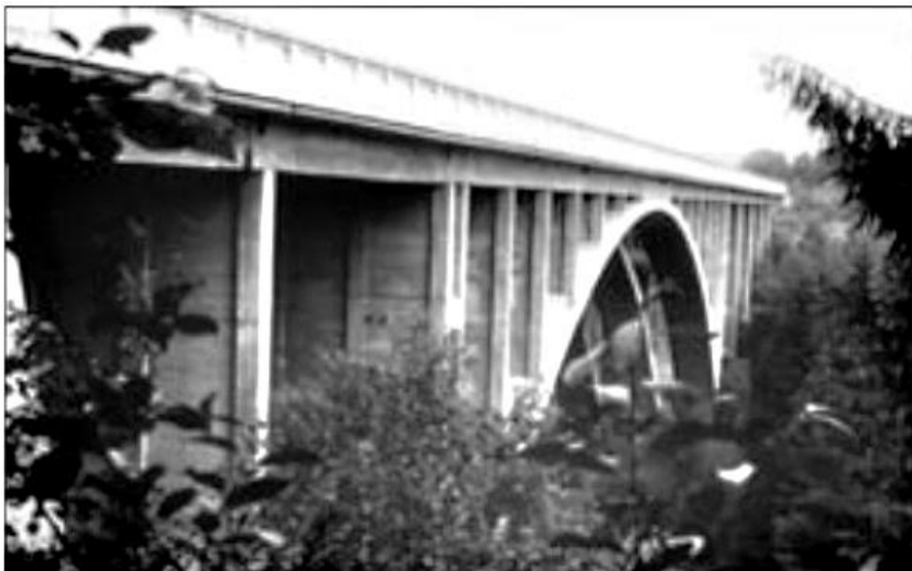
Obr.8 Pohled na dokončený most přes sedlický potok
