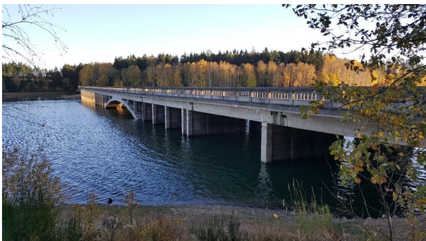
Obr.12 Boční pohled na Most přes Sedlický potok
