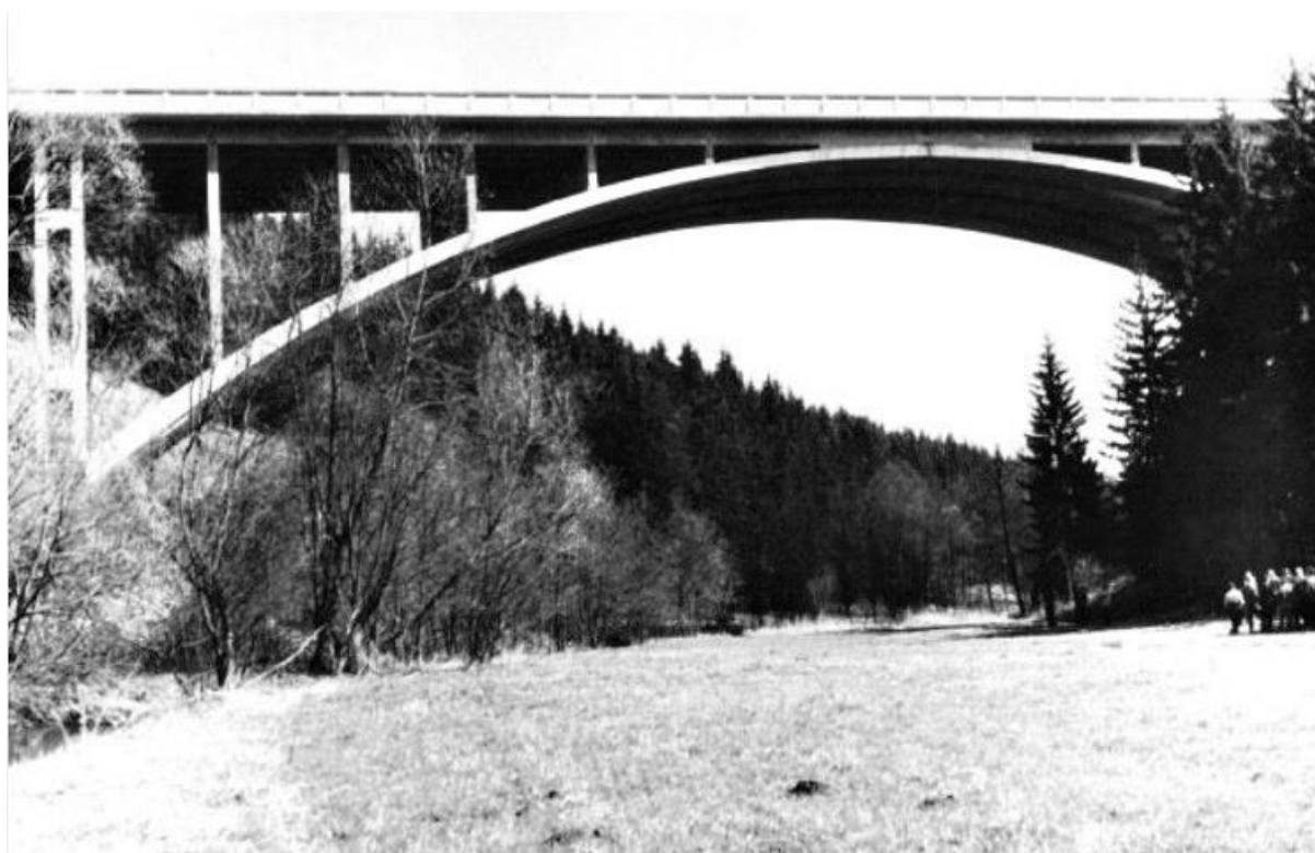
Obr.9 Pohled na most z údolí Sedlického potoka, rok 1964
